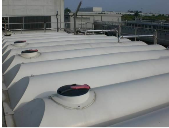
Figura 35 Copertura vasca di stoccaggio VP
