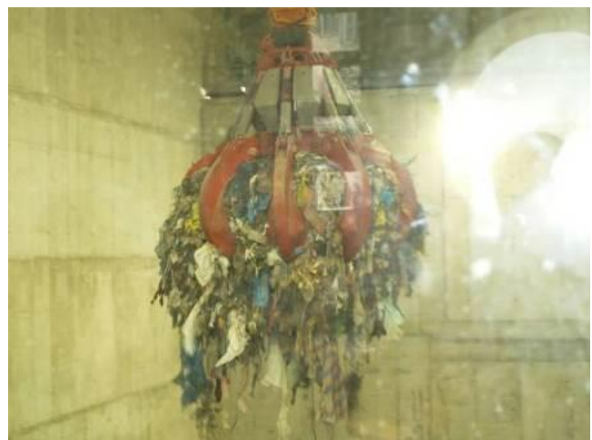
Figura 8 Trasferimento rifiuti nella tramoggia mediante benna a polipo
