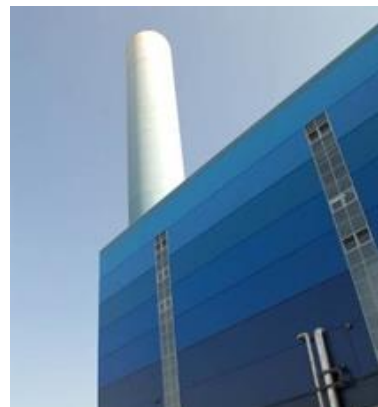
Figura 11 Particolare del camino
